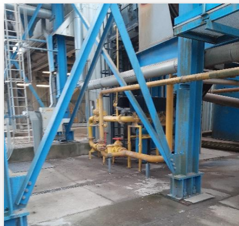
Foto 2 Gasleiding voor de droogtrommels
